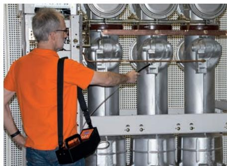
Удлинение измерительного датчика (входит в комплект поставки), оно может быть установлено между устройством и измерительным датчиком, при необходимости позволяет выполнять измерения в точках, к которым затруднен доступ.
